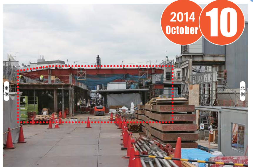
▲将来の駅前広場から見た駅舎の工事状況
