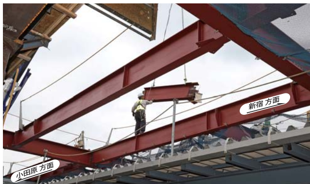
▲駅舎屋根の構築状況
